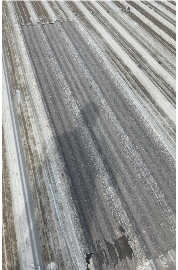
Foto 2. Foto que muestra 1 de los 30 tragaluces de fibra de vidrio situados en la parte superior del edificio donde se produjo el incidente (fotos tomadas antes del incidente).
