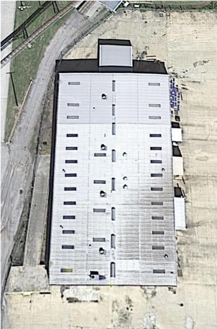
Foto 1. Imagen de Google Earth del edificio donde se produjo el incidente.
