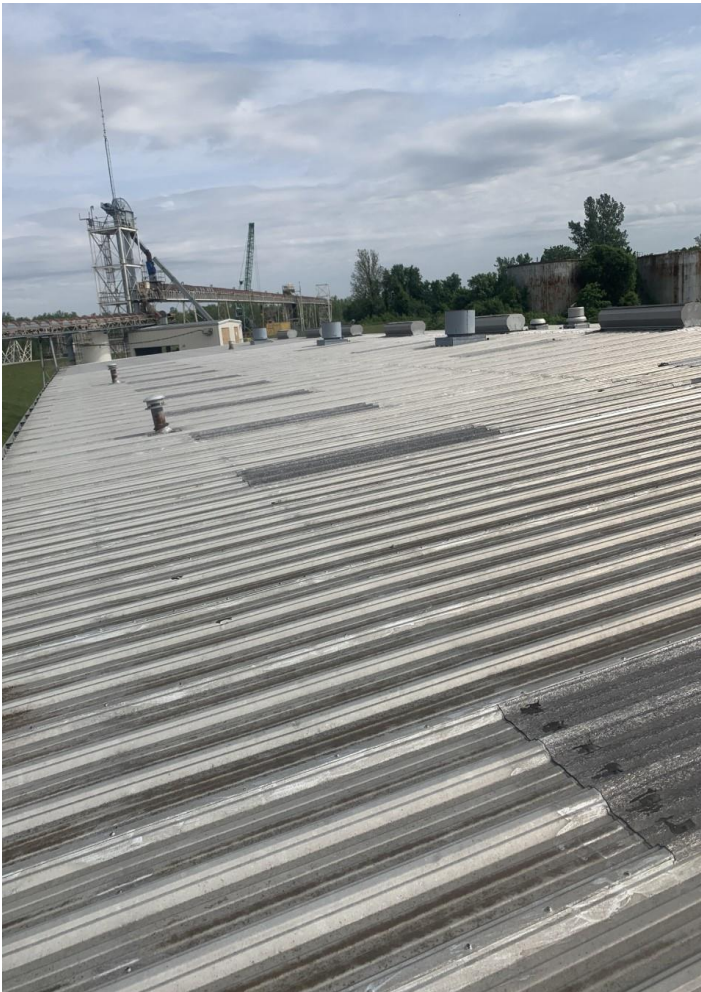
Foto 3. Foto que muestra la colocación de tragaluces de fibra de vidrio y el tejado del edificio donde se produjo el incidente (fotos tomadas antes del incidente).
