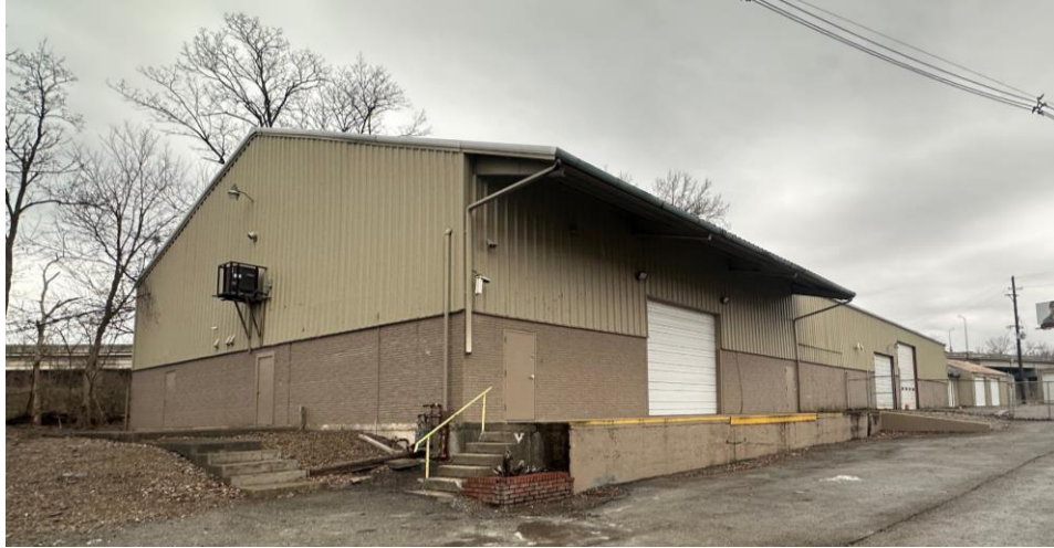
Foto 3. Foto del exterior del edificio donde se produjo el incidente.
