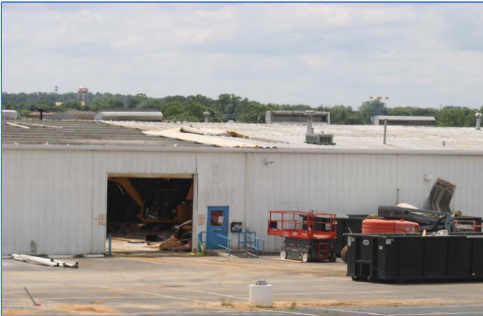
Foto 3. Edificio en proceso de demolición el día del incidente mortal (Cortesía de KyOSHA)
