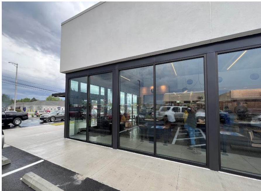
Foto 2. Foto exterior del edificio donde se produjo el incidente.
