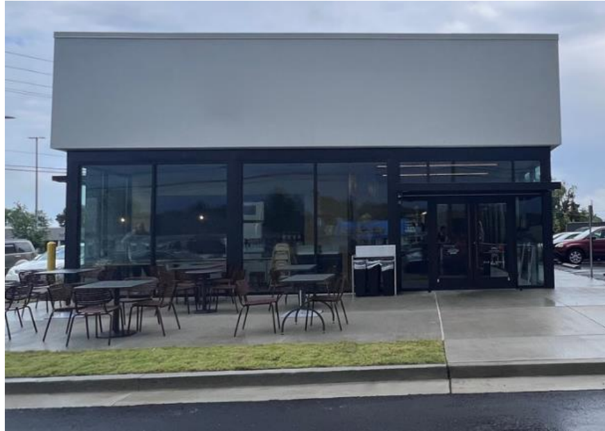
Foto 1. Foto exterior del edificio donde se produjo el incidente.
